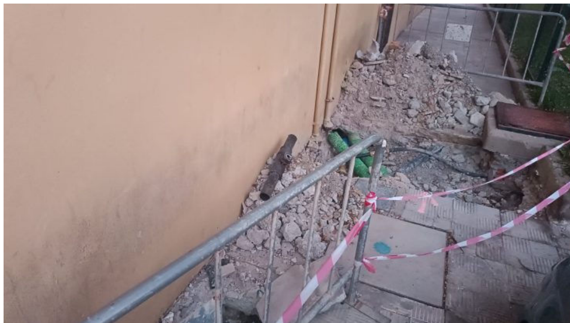
Imagen de la obra. / FOTO: IU
